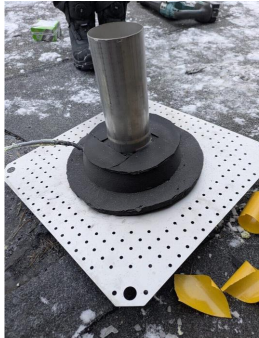
Kuva 4 Uusi kaivo sekä sulanapitokaukalo eristettynä.
