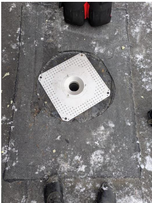
Kuva 5 Uusi kaivo paikallaan.
