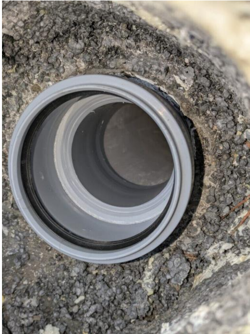
Kuva 3 Uusi irtomuhvi liitetty olemassaolevaan putkeen. Kiinnitetty liimamassalla.
