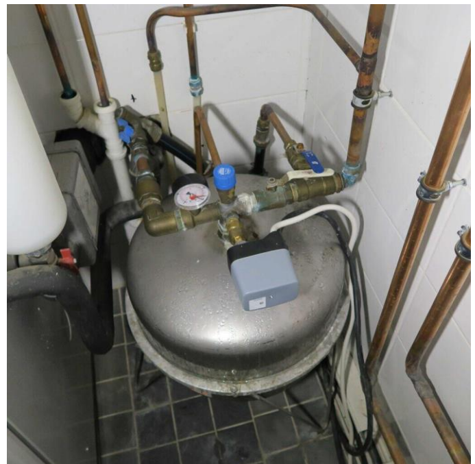
Kuva 4 Vesijohtoverkosto maadoittamaton
