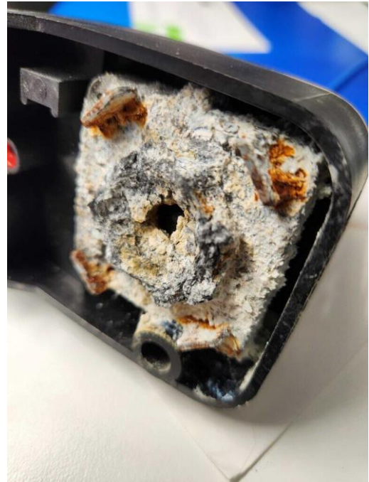
Kuva 6 Painekeytkimen syöpynyt runko
