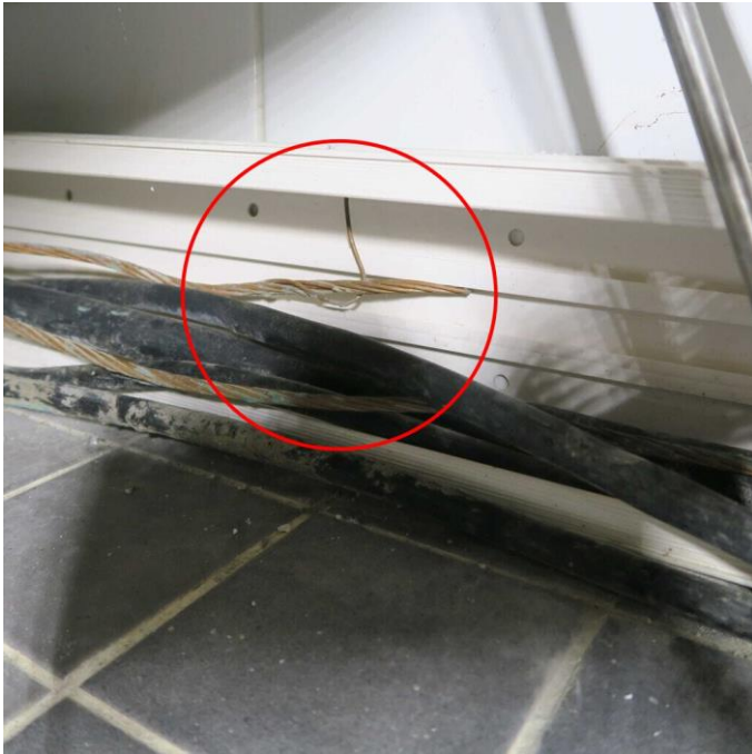
Kuva 5 Maadoitus/potentiaalitasaus kytkemättä lattialla
